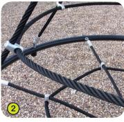
**2- Il cordame Polyfix** Ø16 mm, è composto da sei cavi in acciaio galvanizzato di 0,8 mm rivestiti da polipropilene multifilamento. L'anima è in polipropilene 6x0,7x0,8 mm.
