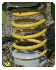
3- Le molle sono in acciaio 35SCD6. La superficie viene trattata dopo la granigliatura di precompressione e rivestita con protezione allo zinco e 2 strati di polvere epossidica di poliestere di 100 micron. Il supporto di sostegno (Brevetto Proludic) in poliammide rinforzata garantisce una conservazione e una sicurezza eccezionale al sistema.
