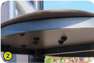
2- **Le piattaforme** sono ricavati da pannelli in HPL strutturato e antiscivolo di spessore 12,5 mm. Essi sono rinforzati da un telaio formato da tubi in acciaio galvanizzato e verniciato.
