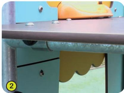
2- **Le piattaforme** sono ricavati da pannelli in HPL strutturato e antiscivolo di spessore 12,5 mm. Essi sono rinforzati da un telaio formato da tubi in acciaio galvanizzato di Ø 40 mm.
