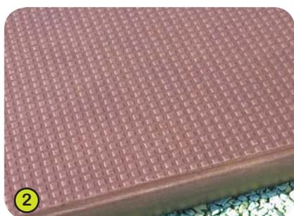
2- **Le piattaforme** sono ricavate da pannelli in HPL strutturato e antiscivolo di spessore 12,5 mm.
