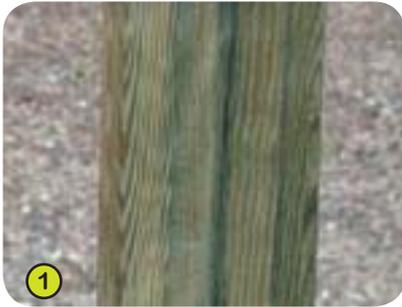
1- I **Montanti a sezione quadrata da 68 x 68 mm di ponte levato** sono in pino lamellare incollato trattato in autoclave senza cromo né arsenico. Ciò previene il legno dall'attacco di di funghi, insetti e termiti. Senza schegge, con scanalature verticali sui quattro lati, il lamellare incollato garantisce grande solidità e stabilità dimensionale.
