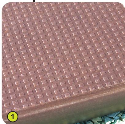
1- La **piattaforma** è ricavata da pannelli in HPL strutturato e antiscivolo di spessore 12,5 mm.
