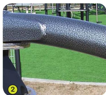
2- I **tubi** sono in acciaio verniciato, con diametro da 60 mm.
