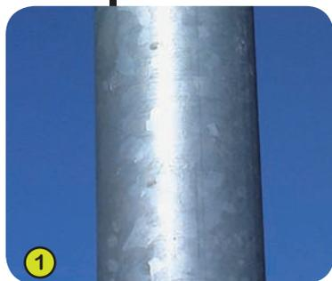
1- I **montanti** sono in acciaio galvanizzato con diametro da 110 mm.
