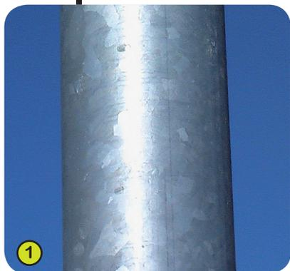
1- **Le montante** è in acciaio galvanizzato con diametro da 114,3 mm.
