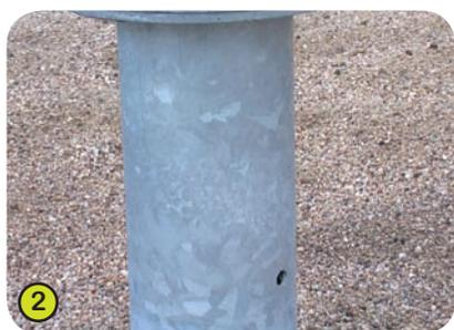
2- **Le montante** è in acciaio galvanizzato con diametro da 90 mm.
